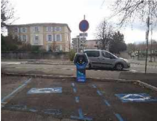
Bornes de recharge à Crest
