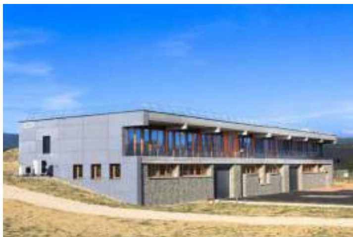
Bâtiment du pôle bio à l'Ecosite d'Eurre
